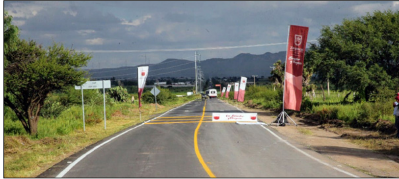
Con la mezcla de recursos entre los Gobiernos del Estado y el municipal de Zacatecas, en esta obra carretera se ejerció una inversión de 8 millones 433 mil 514 pesos y beneficiará a más de mil 500 habitantes de las comunidades Francisco I. Madero, El Magu
